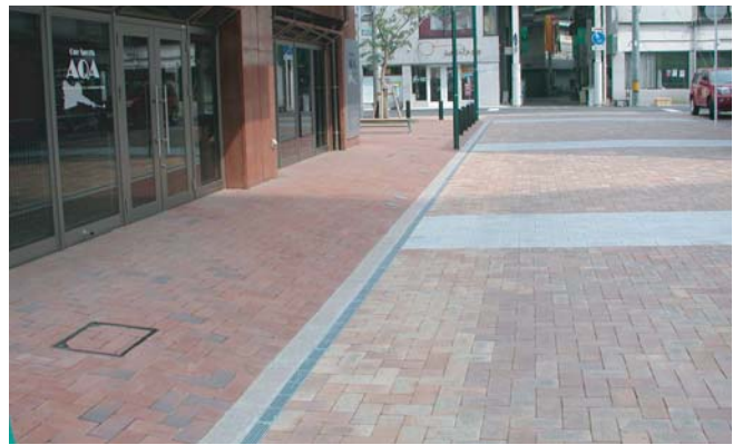
▲街づくり協定により建物1階部分はセットバックされている。また、民間のセットバック部分の舗装については道路の舗装と整合をとることとした。
