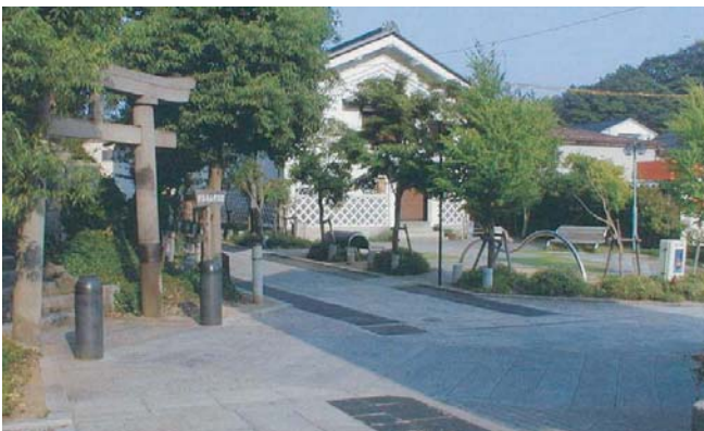
▲自動車整備工場跡の建物を解体した場所を、小公園と通路として整備した。
